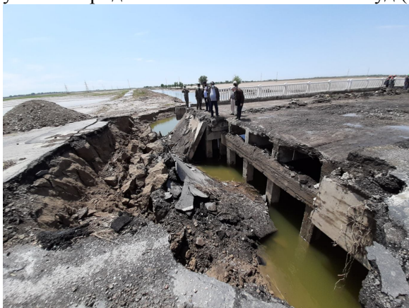
3-расм. Қирғоқ таянчи атрофидаги кўприк ости бўшлиғининг умумий кўриниши
