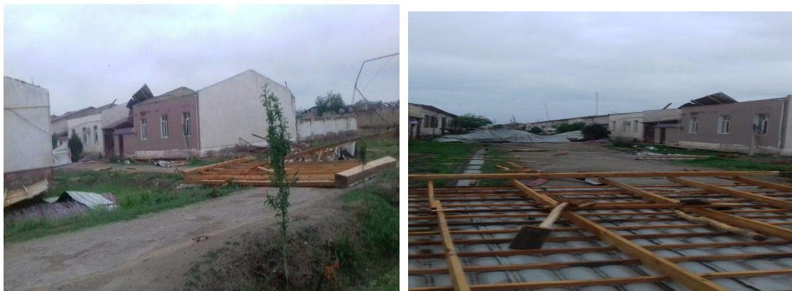
Рис.2. Разрушение сельских типовых домов после воздействия урагана
