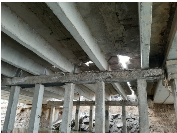
2-расм. Кўприкнинг асосий ва кенгайтирилган қисми оралиқ таянчи конструкциясининг нуқсонлари
