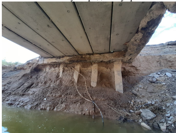
1-расм. Кўприкнинг асосий ва кенгайтирилган қисми қирғоқ таянчларининг умумий кўриниши ва нуқсонлари
