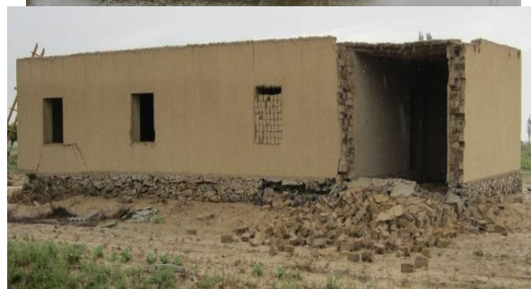
1-расм. Деворлари хом ғиштдан (пахсадан) қурилган уйларни сув таъсирида мустаҳкамлигини йўқотишидан бузилиш ҳолатлари
