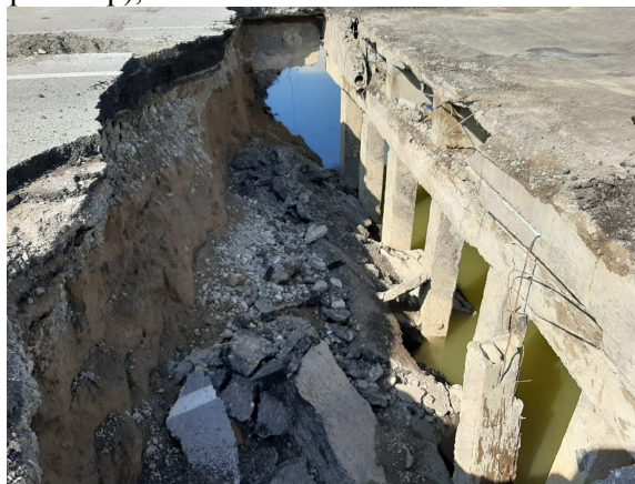
3-расм. Қирғоқ таянчи атрофидаги кўприк ости бўшлиғининг умумий кўриниши
