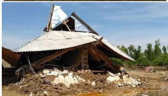
1-расм. Деворлари хом ғиштдан (пахсадан) қурилган уйларни сув таъсирида мустаҳкамлигини йўқотишидан бузилиш ҳолатлари
