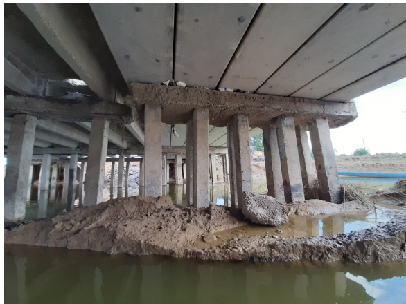
2-расм. Кўприкнинг асосий ва кенгайтирилган қисми оралиқ таянчи конструкциясининг нуқсонлари
