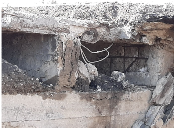
6-расм. Оралиқ қурилма тўсинларини сарровга жойлаштириш жойидаги нуқсон ва шикастланишлар
