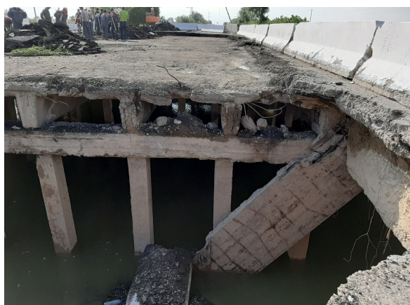
4-расм. Кўприкнинг асосий ва кенгайтирилган қисмларини бирлаштирувчи чокнинг кўриниши
