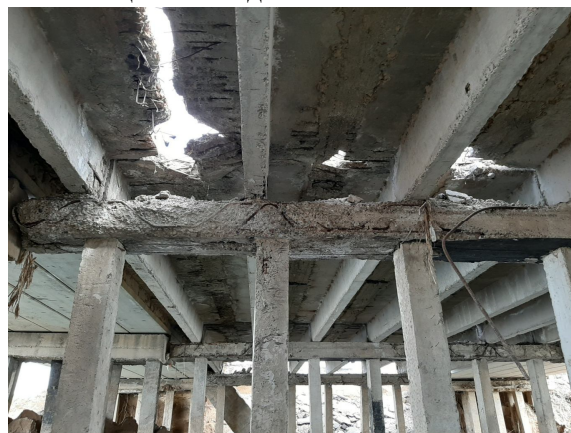
7-расм. Кўприк асосий қисмидаги оралиқ қурилма конструкцияларининг нуқсонлари
