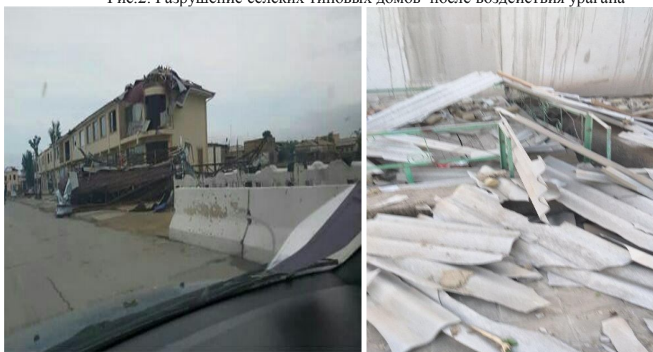
Рис. 3. Разрушение двухэтажных государственных помещений после воздействия урагана
